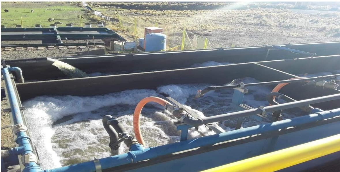
**Figura 23:** Cámara de biomembranas
