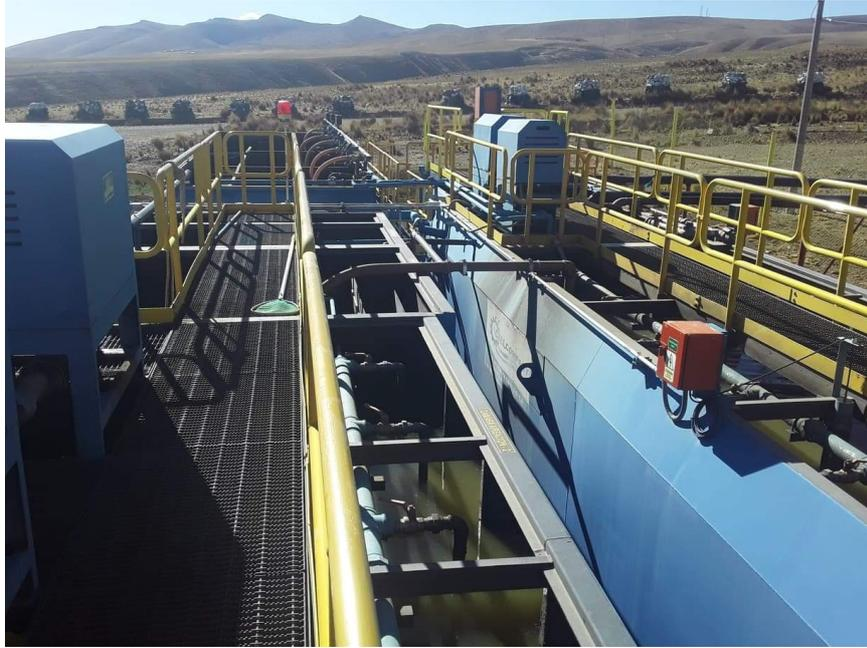
**Figura 22:** Cámara de aireación 1 y 2.
