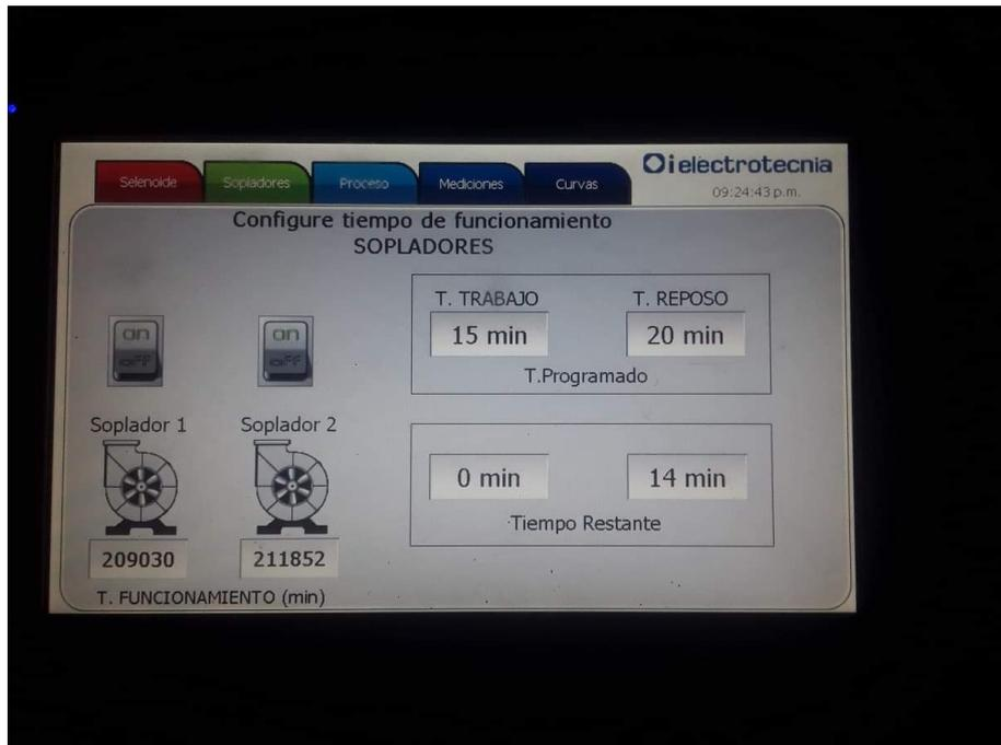
Figura 27: Tablero de control de la PTARD
